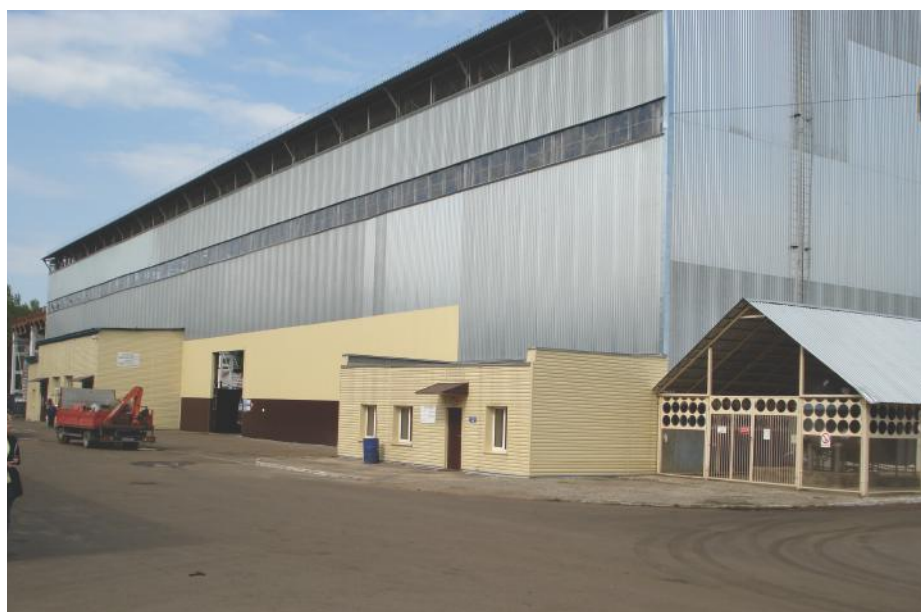
Крытый цех комплексной переработки металлолома после модернизации.
