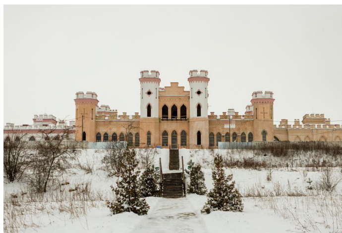
Коссовский замок — в процессе реконструкции.
