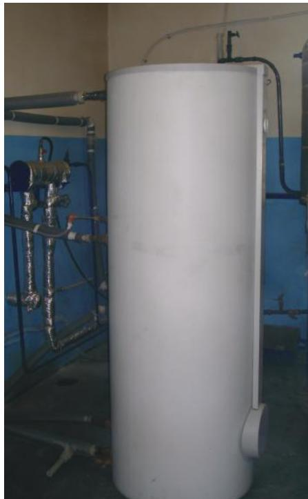
В баке-аккумуляторе емкостью 500 литров происходит подогрев воды.
