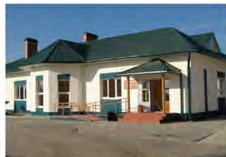
Новый административно-бытовой корпус Кобринского участка по ул. Пролетарской, 183 соответствует самым высоким современным требованиям.
